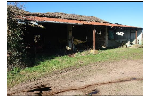
Ancien bâtiment agricole de La Billoterie Source : Artifex 2020
