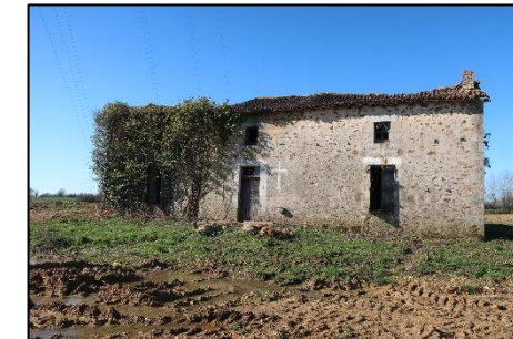
Ruine de la Naulerie Source : Artifex 2020
